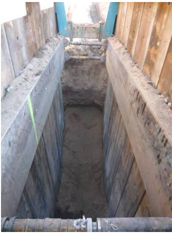
7. Excavació del sisè tram finalitzada
