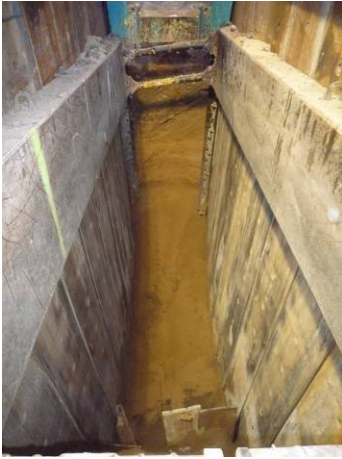
9. Excavació del vuitè tram finalitzada.
