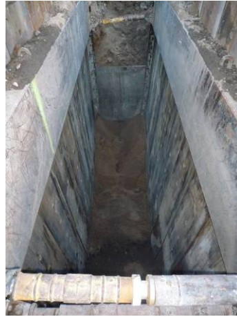
10. Excavació del novè tram finalitzada.
