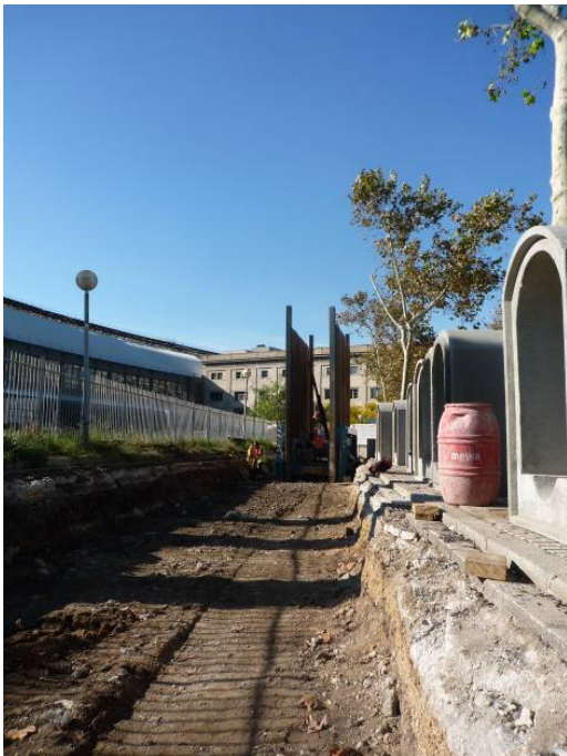
Superfície de la rasa amb màquina entibadora.
