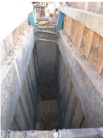
11. Excavació del desè tram finalitzada
