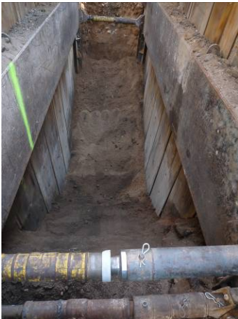
3. Excavació del segon tram finalitzada.
