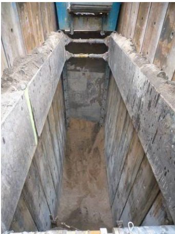
5. Excavació del quart tram finalitzada.
