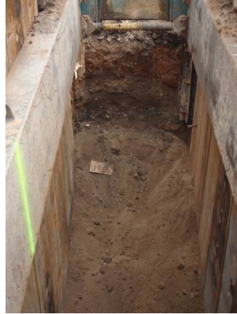
2. Excavació del primer tram finalitzada.
