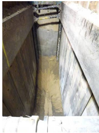
8. Excavació del setè tram finalitzada.
