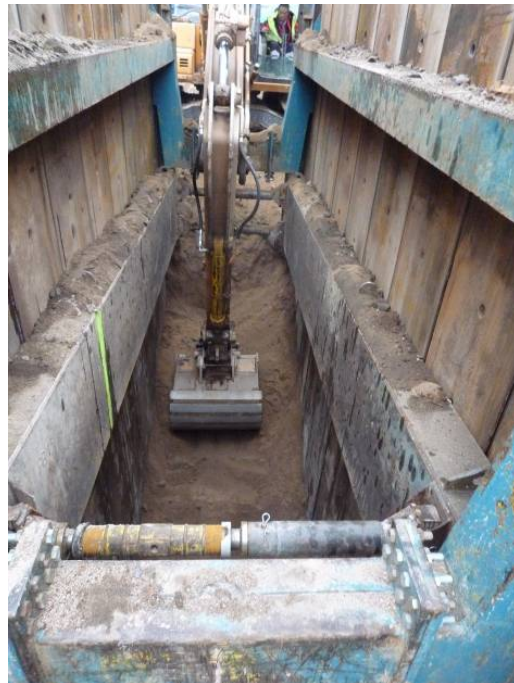
Excavació de la rasa.
