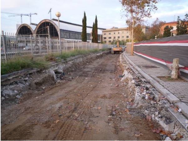
1. Vista general de l'obra un cop retirades les UE 100 i 101
