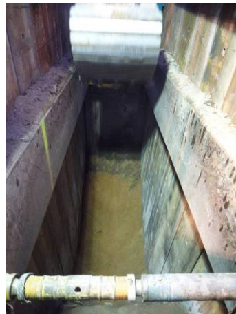
6. Excavació del cinquè tram finalitzada.
