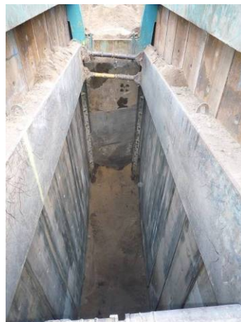
12. Excavació de l'onzè tram finalitzada.
