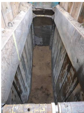
13. Excavació del dotzè tram finalitzada.
